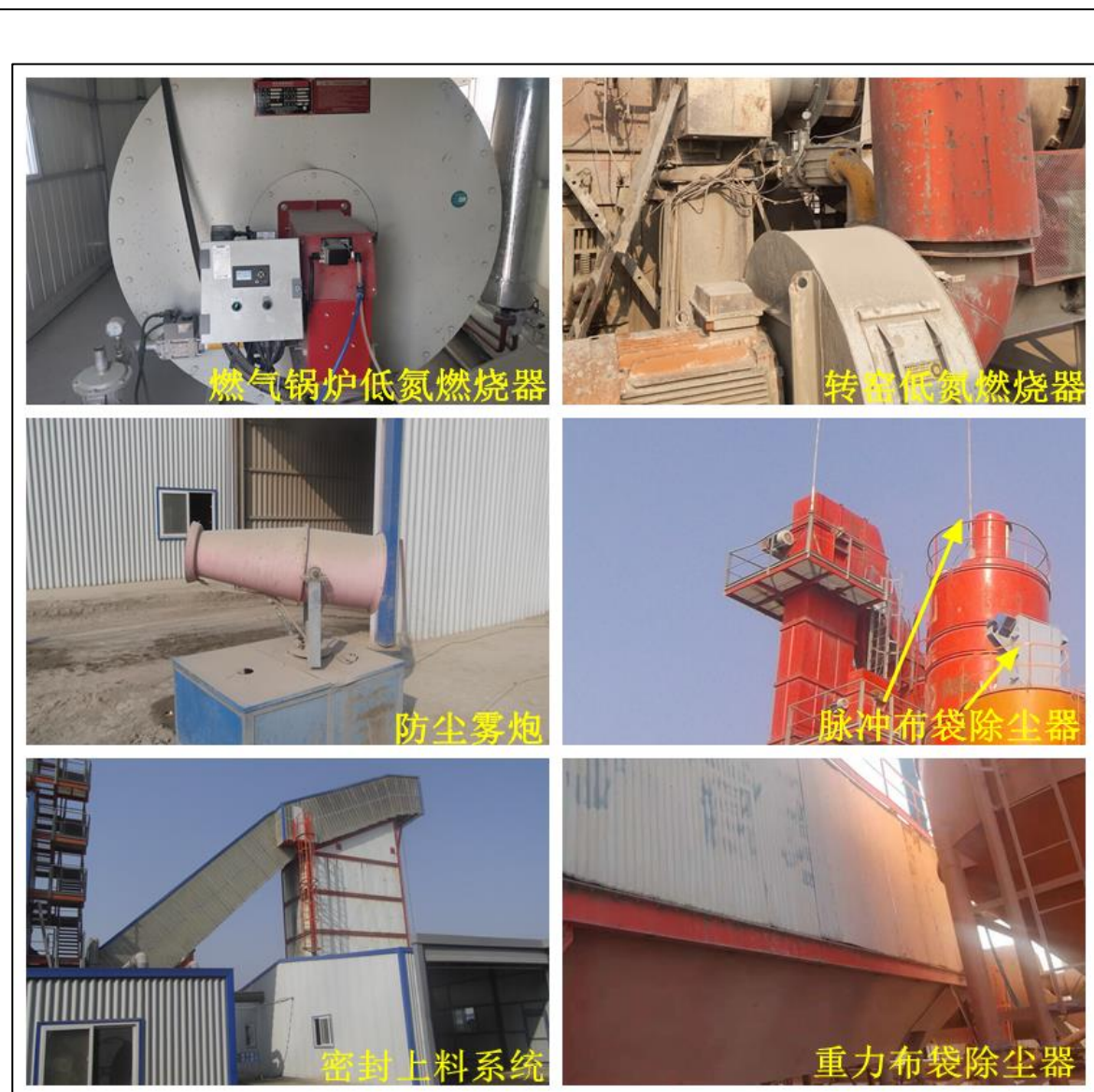
图 3-3 项目废气处理设施/措施
