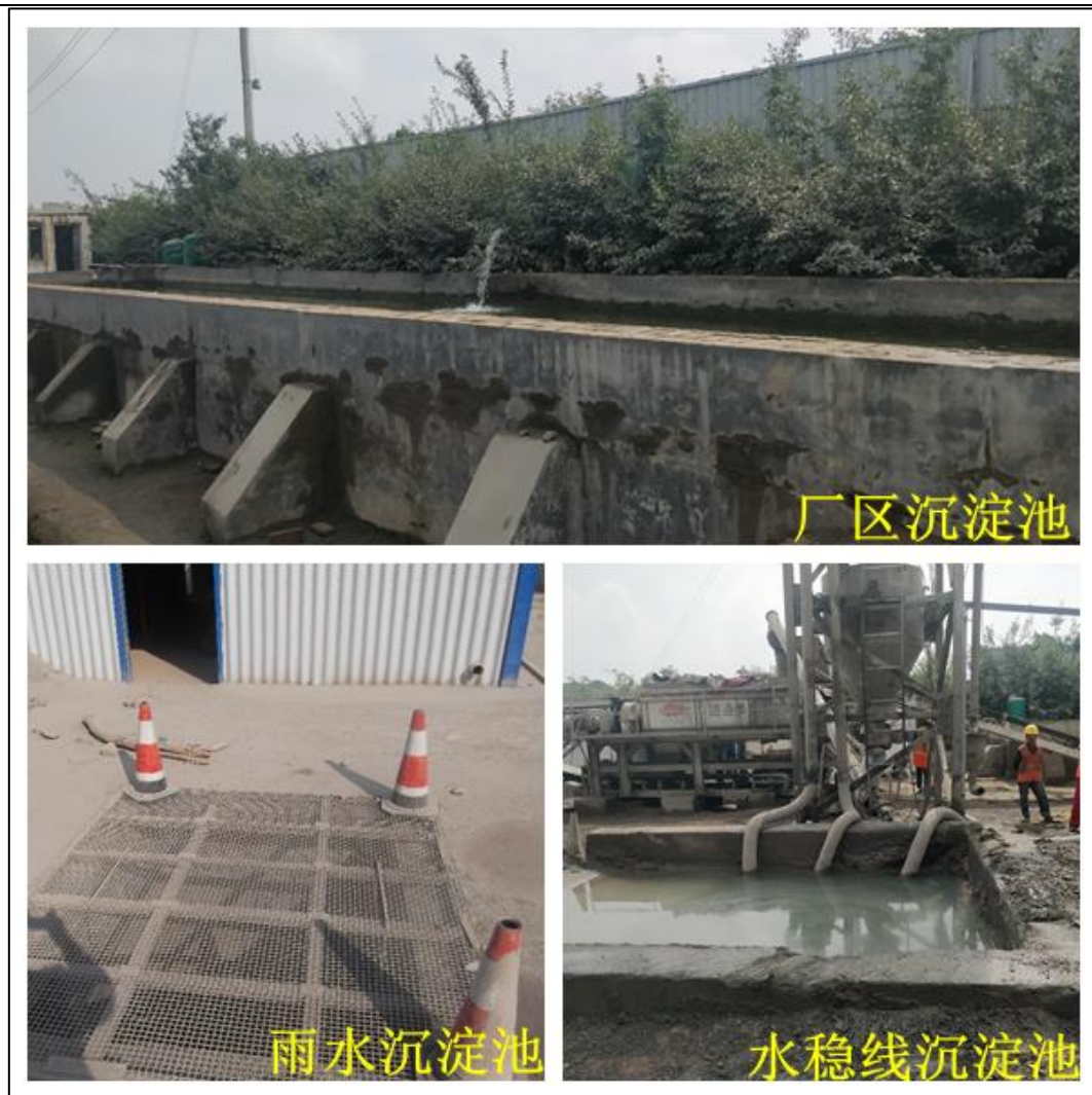
图 3-5 厂区循环水沉淀池
